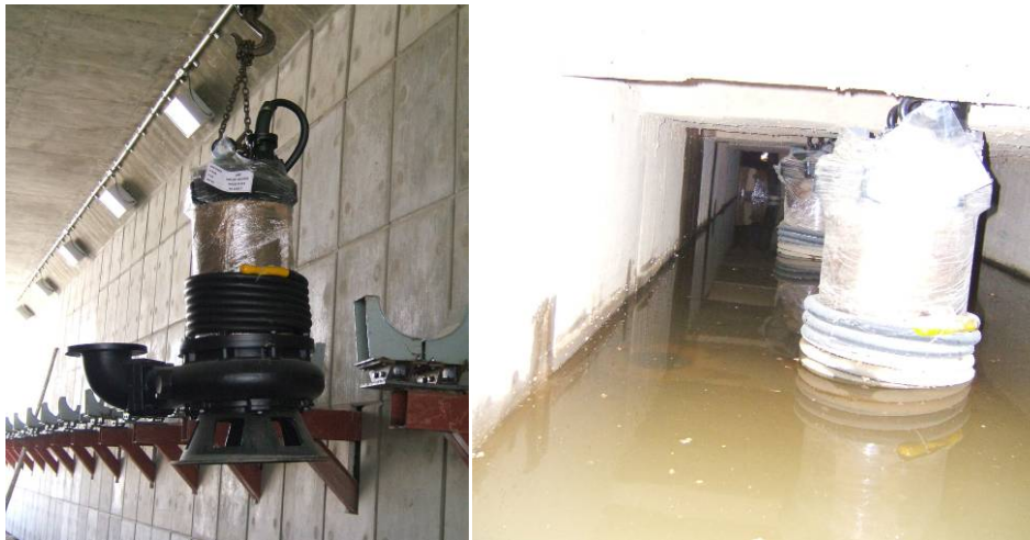
รูปที่ 6-4 แสดงการติดตั้งเครื่องสูบน้ำลงในบ่อพัก
