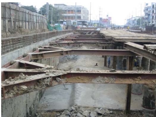
รูปที่ 4-6 ระบบค้ำยันและงานขุดดิน
