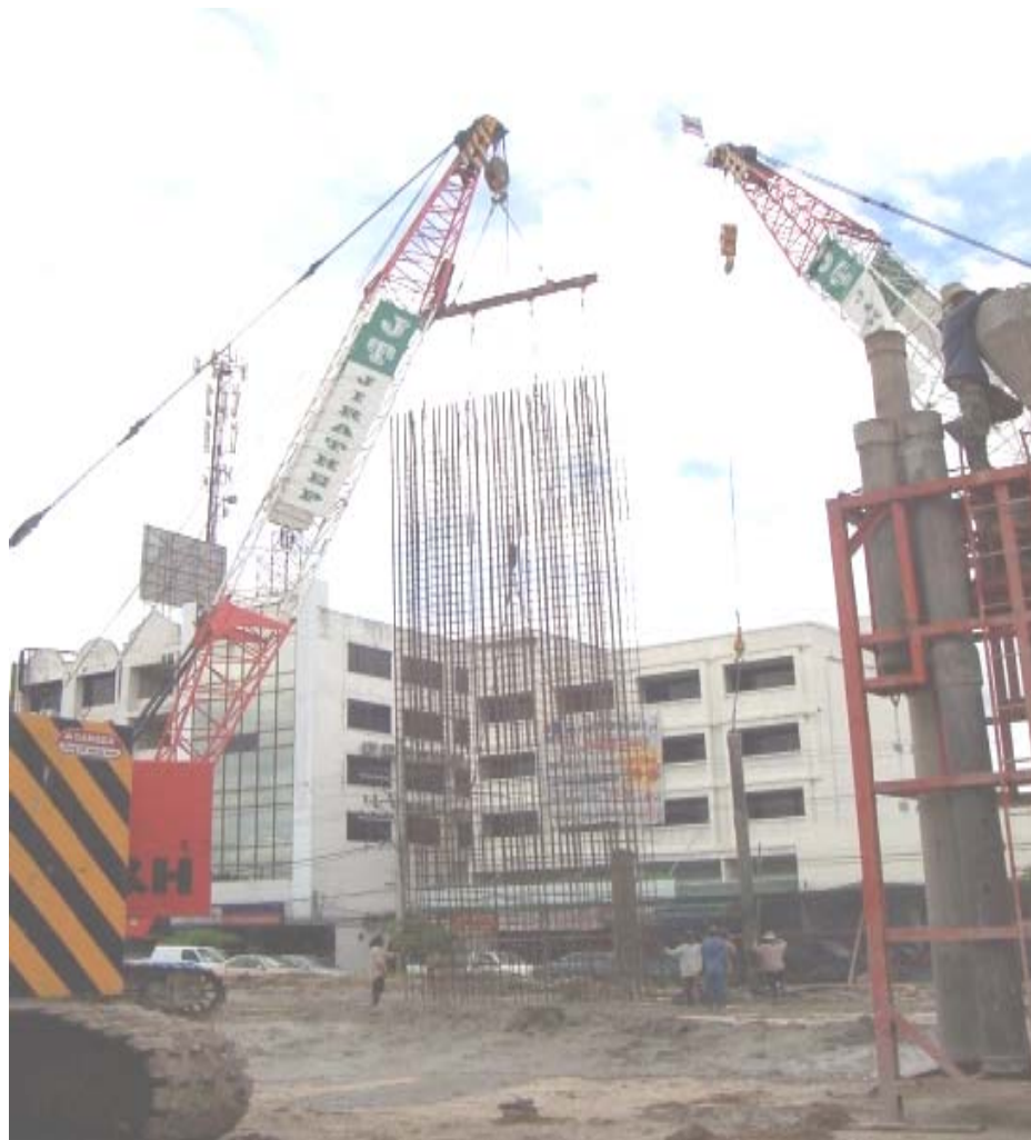
รูปที่ 3-34 การติดตั้งเหล็กเสริมที่เตรียมไว้ลงในหลุมเจาะผนัง
