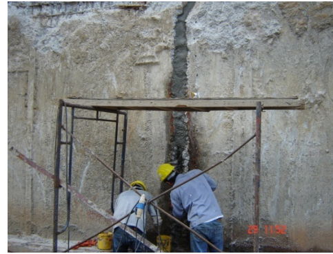
(ง) การปิดอุดรอยต่อระหว่างแผงคอนกรีตผนังที่ปิดด้วยปูนซีเมนต์ผสม ก่อนการอัดฉีดสารเคมี
