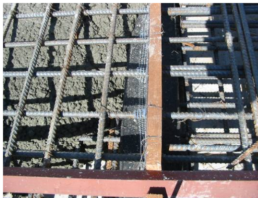
รูปที่ 4-14 ติดตั้งระบบป้องกันน้ำใต้ดินรั่วซึม (Water Stop) ที่ Construction Joint
