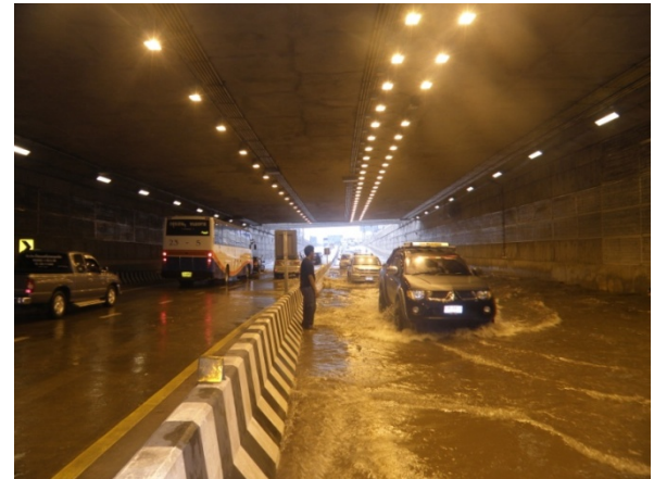
รูปที่ 10-5 ปัญหาน้ำท่วมขังในทางลอดเนื่องจากระบบปั๊มไม่ทำงาน
