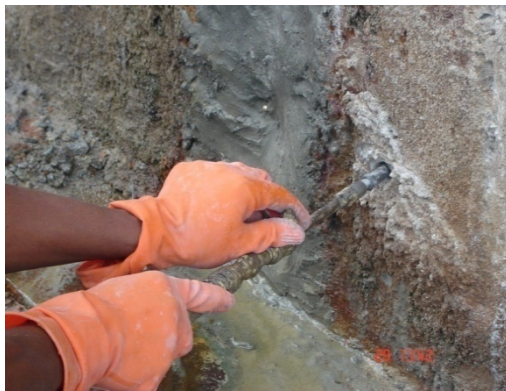
(จ) การอัดฉีดวัสดุเคมีตามหัวฉีดเพื่อให้แทรกซึมเข้าไปตามรอยร้าวซึม
