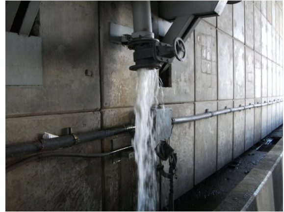
รูปที่ 10-4 เจ้าหน้าที่แขวงทางเชียงใหม่ตรวจสอบการทำงานของระบบระบายน้ำ
