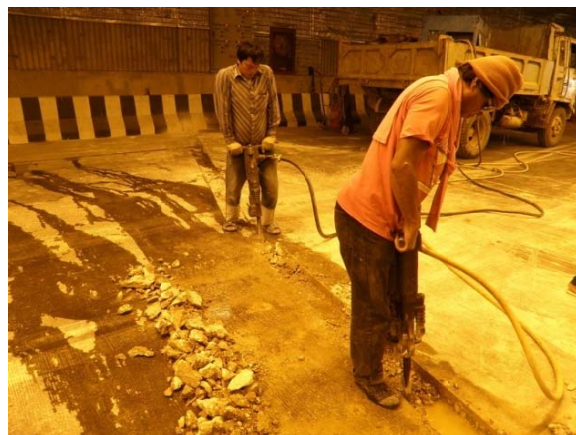
รูปที่ 10-1 ตรวจสอบและซ่อมแซมผิวจราจรโดยเจ้าหน้าที่แขวงทางขอนแก่นที่ 1
