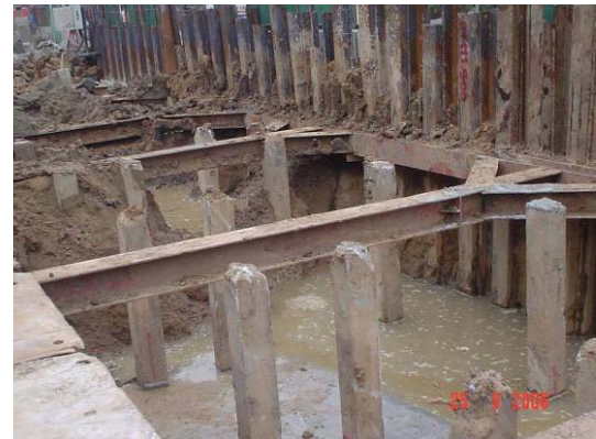
รูปที่ 4-7 ภายหลังจากขุดจนใกล้เคียงระดับที่ต้องการ
