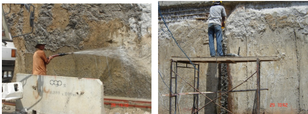
(ข) ล้างทำความสะอาดและสกัดแต่งเนื้อคอนกรีตที่ไม่ดีของแผงคอนกรีตผนังปิด
