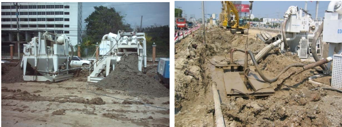
รูปที่ 3-28 แสดงขั้นตอนการทำความสะอาดกันหลุมด้วยเครื่อง Desander Unit
