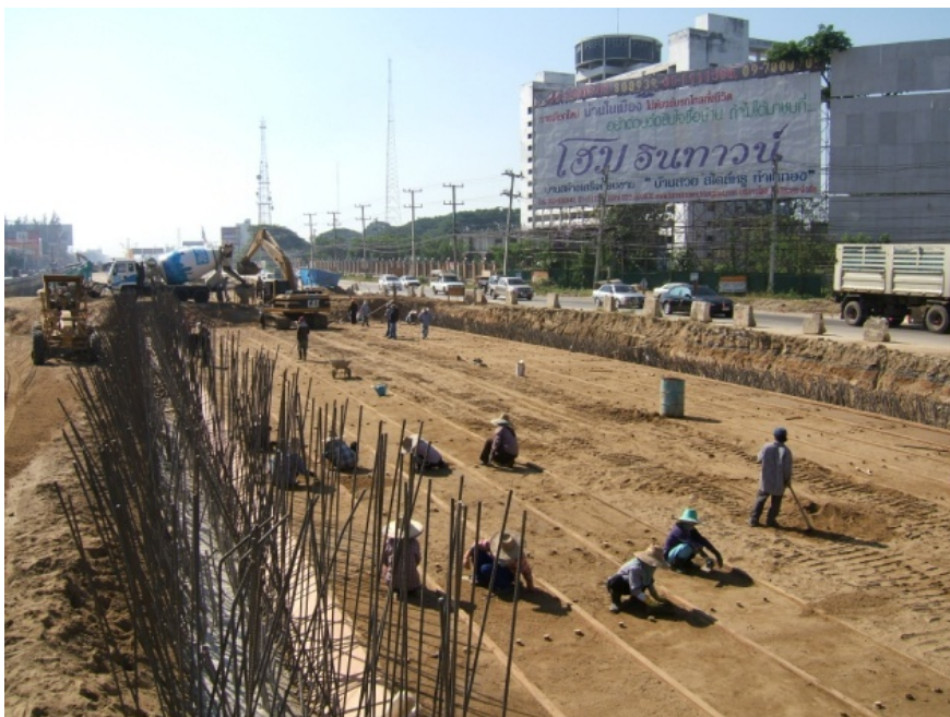
พื้นดินที่บดทับแน่น และเสริมด้วยเสาเข็มไม้
