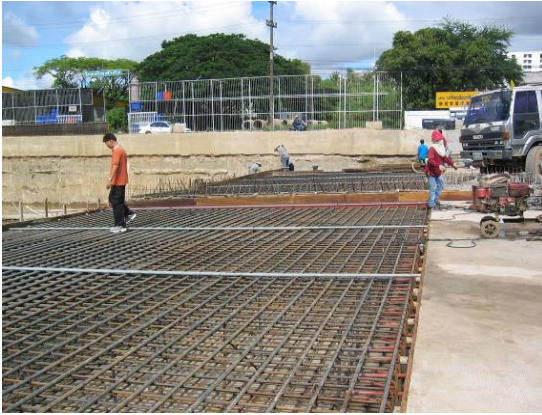
รูปที่ 4-12 การตรวจสอบระดับหลังทางและการทำความสะอาดพื้นก่อนเทคอนกรีต
