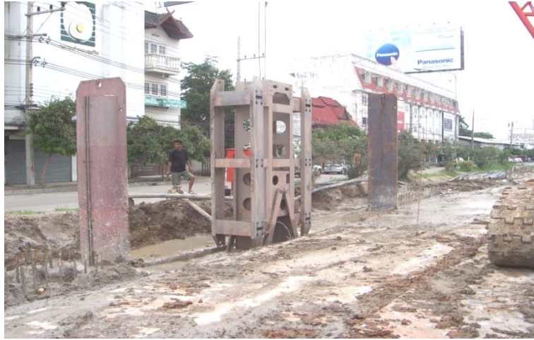
รูปที่ 3-31 การชุด Diaphragm Wall
