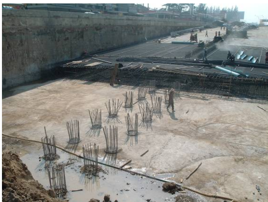
รูปที่ 4-11 เหล็กเสริมพื้น Base Slab
