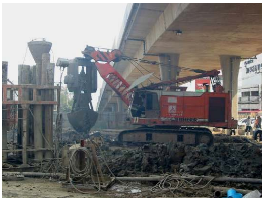
รูปที่ 4-5 เสาค้ำ Barrette Pile สำหรับโครงสร้าง Base Slab
