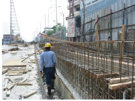
ผูกเหล็ก Retaining wall
