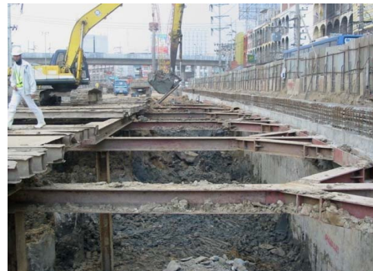
รูปที่ 4-6 ระบบค้ำยันและงานขุดดิน
