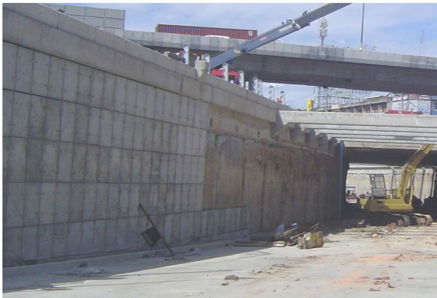
รูปที่ 3-36 แผ่นคอนกรีตหล่อสำเร็จสำหรับงานผนังทางลอด
