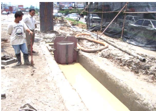
รูปที่ 3-30 การติดตั้ง Stop End Plates
