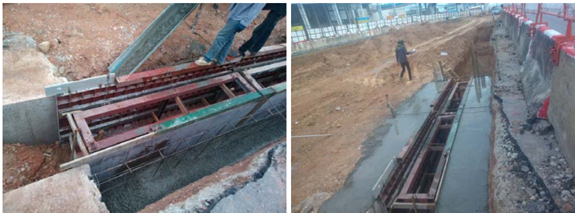
รูปที่ 3-23 แสดงคานบังคับแนวกำแพง หรือผนังนำร่อง (Guide Wall) ก่อนทำการขุดดิน
