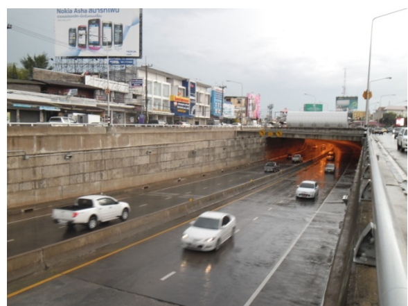
รูปที่ 10-6 ปัญหาการระบายน้ำในทางลอดที่เชื่อมโยงกับท่อสาธารณะของทางลอดขอนแก่น กรณีฝนตกหนัก วันที่ 17 พฤษภาคม 2556 เวลา 16.00 น.
