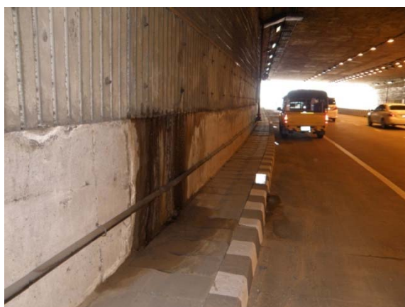
รูปที่ 10-2 ปัญหาน้ำใต้ดินที่รั่วซึมผ่านผนังทางลอด
