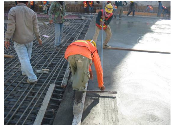
รูปที่ 4-13 แสดงการเทคอนกรีตพื้น Base Slab
