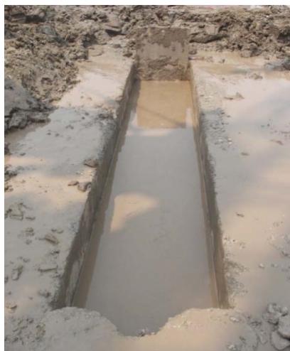
รูปที่ 3-25 การรักษาเสถียรภาพของหลุมด้วยสารละลาย ระหว่างการขุด
