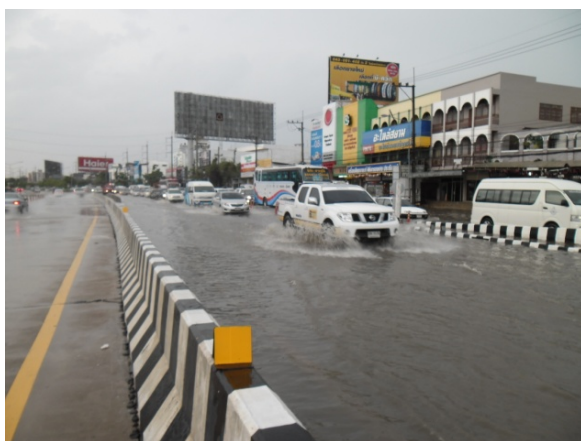
รูปที่ 10-6 ปัญหาการระบายน้ำในทางลอดที่เชื่อมโยงกับท่อสาธารณะของทางลอดขอนแก่น กรณีฝนตกหนัก วันที่ 17 พฤษภาคม 2556 เวลา 16.00 น.
