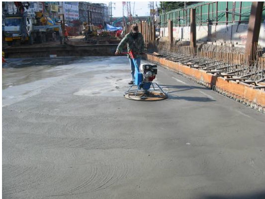
รูปที่ 4-13 แสดงการเทคอนกรีตพื้น Base Slab
