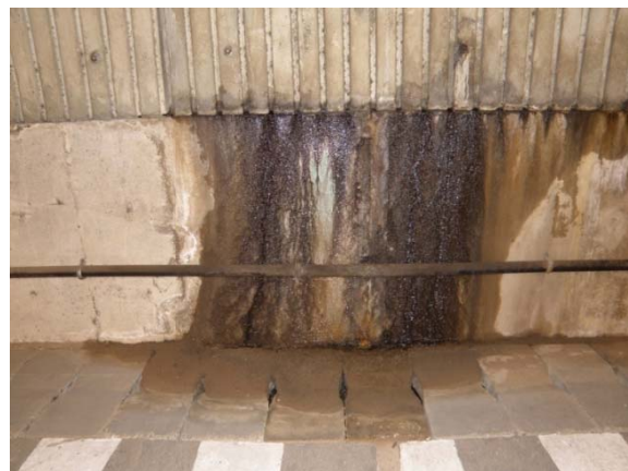
รูปที่ 10-2 ปัญหาน้ำใต้ดินที่รั่วซึมผ่านผนังทางลอด
