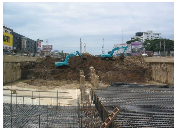
รูปที่ 4-11 เหล็กเสริมพื้น Base Slab
