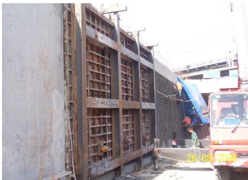
รูปที่ 3-45 เเทคอนกรีตกำแพงหน้า
