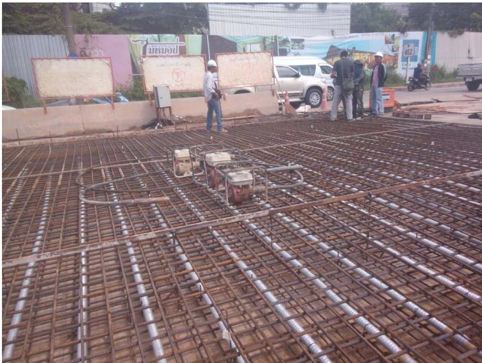
รูปที่ 5-11 งานเหล็กเสริมและลวดอัดแรง
