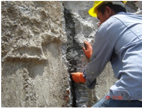
(ง) การปิดอุดรอยต่อระหว่างแผงคอนกรีตผนังที่ปิดด้วยปูนซีเมนต์ผสม ก่อนการอัดฉีดสารเคมี
