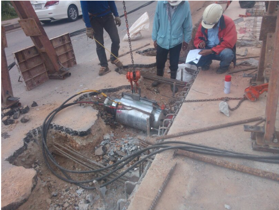
รูปที่ 5-12 งานอัดแรงเมื่อคอนกรีตได้กำลังตามที่กำหนด
