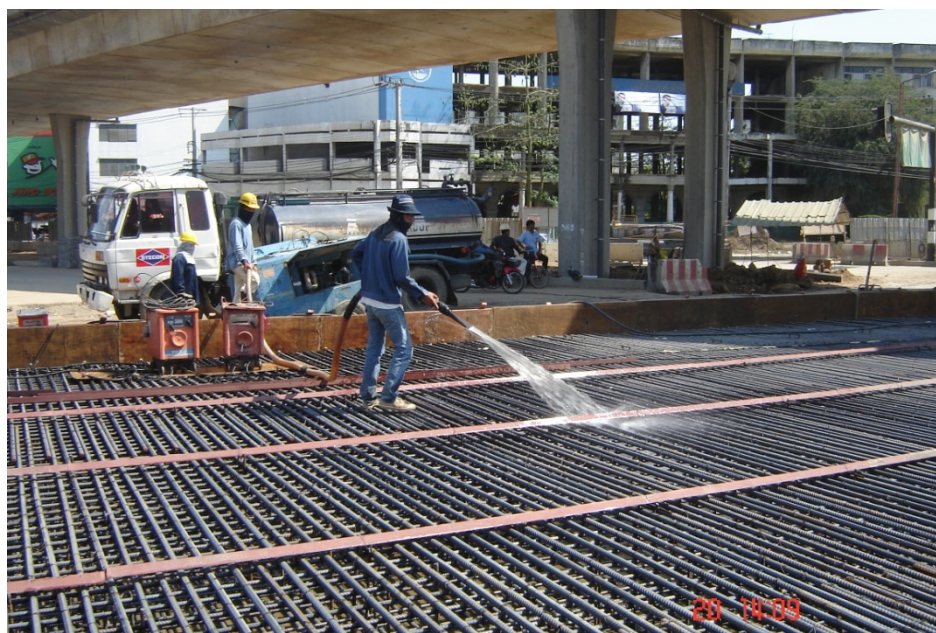
รูปที่ 5-4 งานเหล็กเสริมและทำความสะอาด
