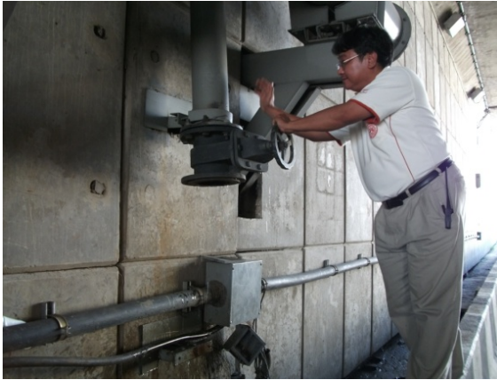
รูปที่ 10-4 เจ้าหน้าที่แขวงทางเชียงใหม่ตรวจสอบการทำงานของระบบระบายน้ำ
