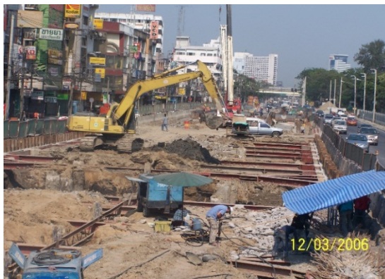
รูปที่ 3-42 เครื่องจักรขุดเปิดหน้าดินและติดตั้งค้ำยัน
