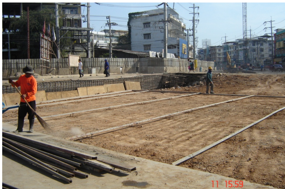
การเตรียมพื้นที่ก่อนเทคอนกรีตหยาบ
