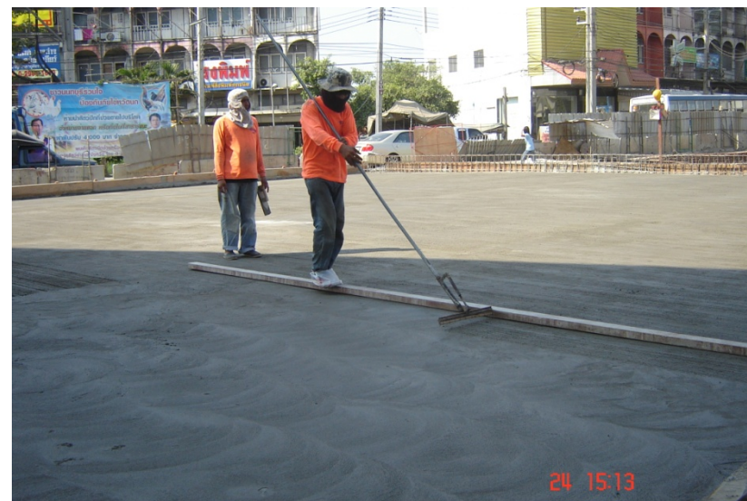
รูปที่ 5-5 งานเทคอนกรีตและเก็บรายละเอียดผิวคอนกรีต
