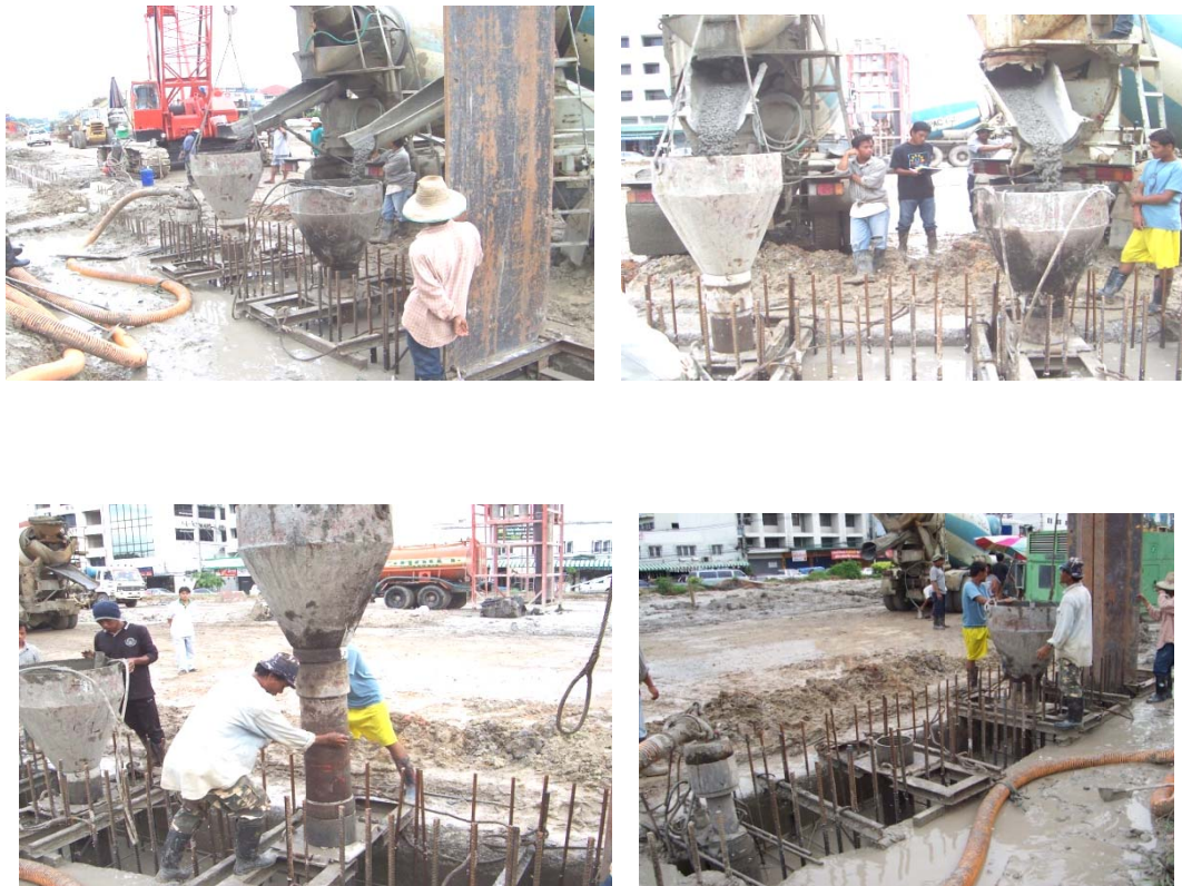
รูปที่ 3-35 การเทคอนกรีตผนังพืด (Diaphragm Wall) โดยใช้ท่อเทคอนกรีต (Tremie Pipe)
