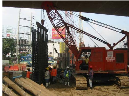
รูปที่ 4-5 เสาค้ำ Barrette Pile สำหรับโครงสร้าง Base Slab
