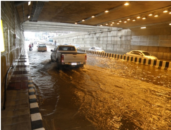
รูปที่ 10-5 ปัญหาน้ำท่วมขังในทางลอดเนื่องจากระบบปั๊มไม่ทำงาน
