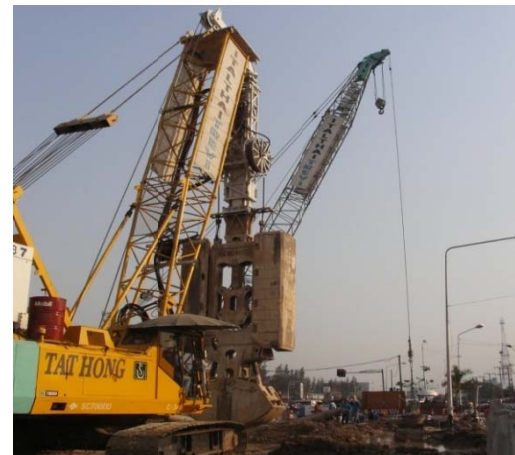
รูปที่ 3-9 เครื่องจักรขุดดินสำหรับก่อสร้างผนังพืดแบบ Cable Hang Grab
