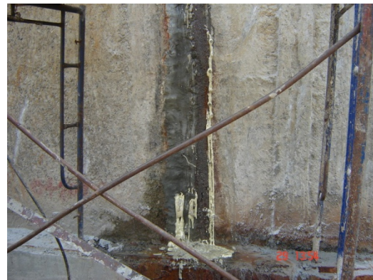
(จ) การอัดฉีดวัสดุเคมีตามหัวฉีดเพื่อให้แทรกซึมเข้าไปตามรอยร้าวซึม
