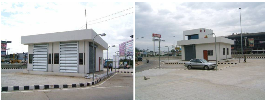
รูปที่ 6-6 อาคารควบคุมเครื่องสูบน้ำ (Control Building)
