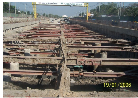
รูปที่ 3-42 เครื่องจักรขุดเปิดหน้าดินและติดตั้งค้ำยัน
