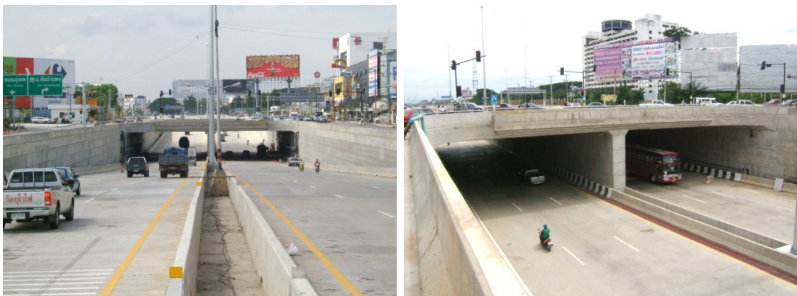
รูปที่ 5-7 โครงการก่อสร้างแล้วเสร็จ
