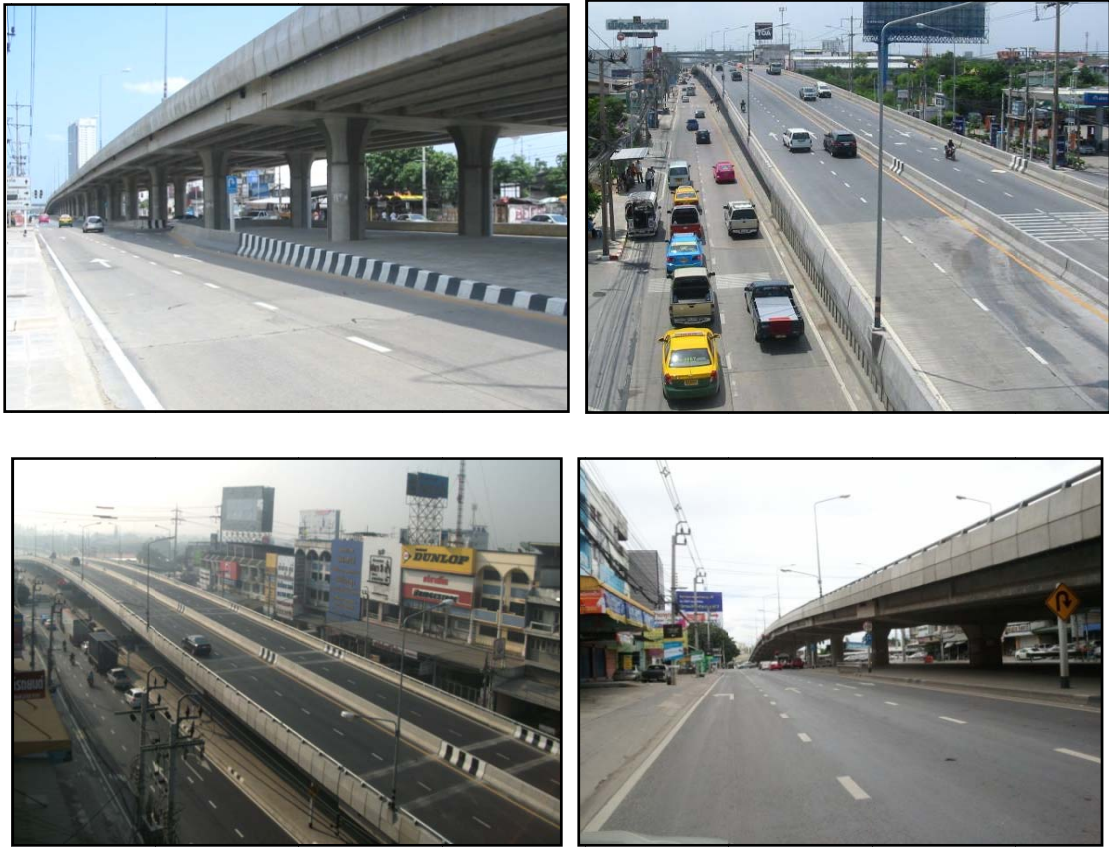
รูปที่ 1-1 สะพานลอยข้ามทางแยก (Overpass)
