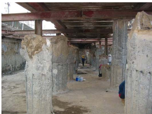
รูปที่ 4-7 ภายหลังจากขุดจนใกล้เคียงระดับที่ต้องการ
