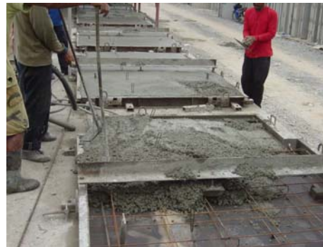
2. เทคอนกรีต
