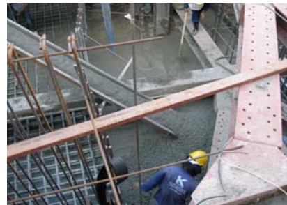
การเทคอนกรีตโดยใช้รางเท
