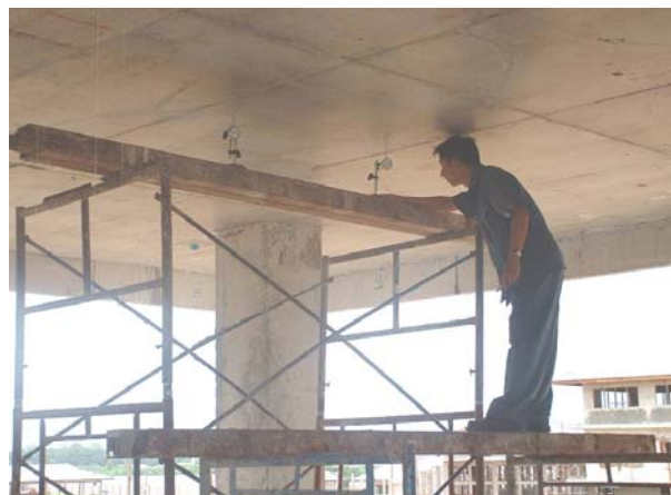
การทดสอบให้โครงสร้างรับน้ำหนักจริง
