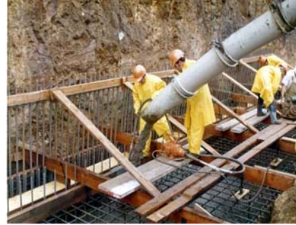
การเทคอนกรีตโดยการต่อท่อ
