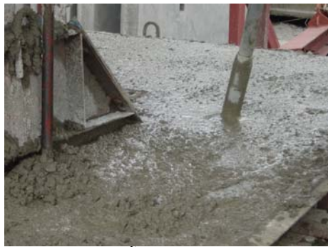
3. การจี้เขย่าคอนกรีต
