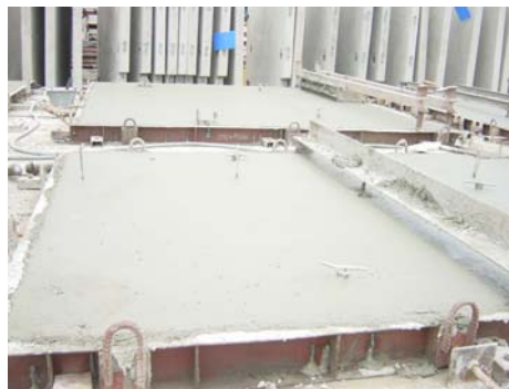
5. คอนกรีตกำลังเซตตัว
