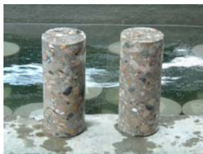
คอนกรีตที่ถูกเจาะโดยเครื่องเจาะคอนกรีต
