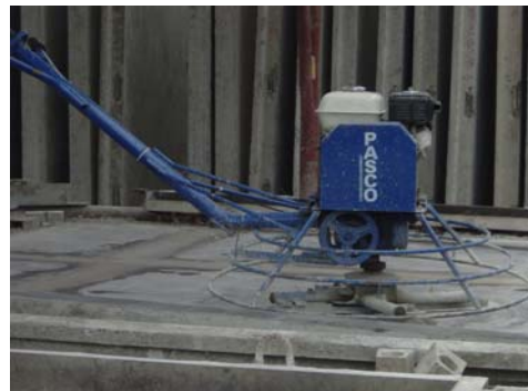
6. ขัดพื้นผิวหน้าคอนกรีต
