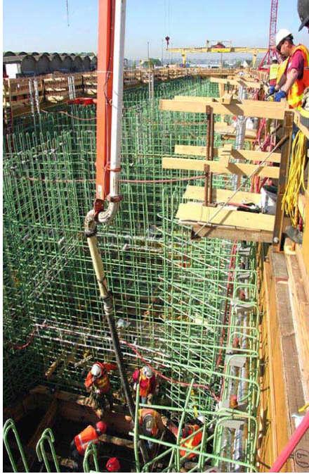
การเทคอนกรีตโดยใช้ปั๊มยิงคอนกรีต
